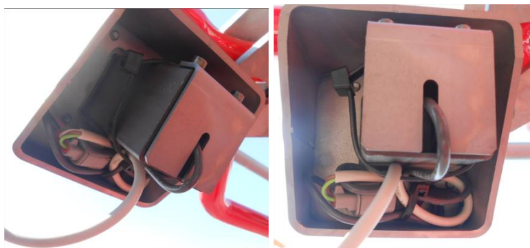
Konnektor (CN06) anbragt i støtteboksen (æstetisk og sikkert)
