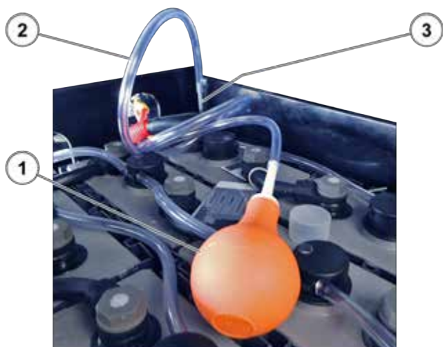
Figur 170: Tømning af højspændingsbatteriernes bakker
