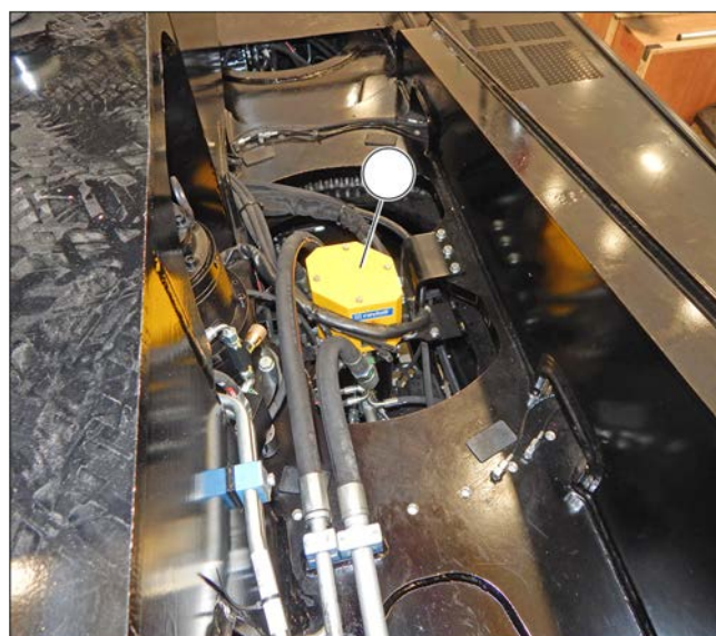
Figur 224: Kontroller og rengør transmitteringene på den roterende elektriske opsamler
