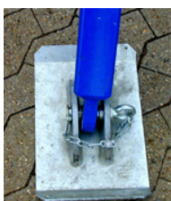
Fig. 14 Fodplade monteret og sikret.
