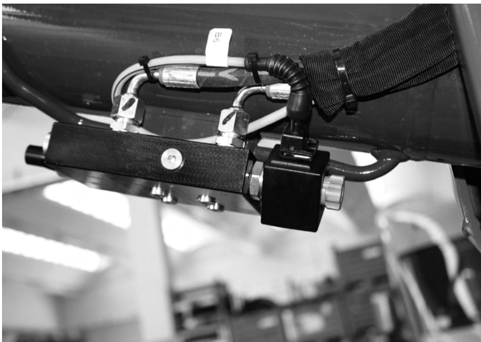
Fig. 73 Elektromagnetiske ventiler til nødnedstigning pga. tyngdekraft
